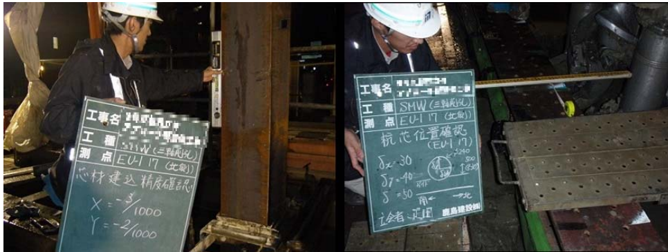
図 4-2-1 : 削孔・鉛直度測量
