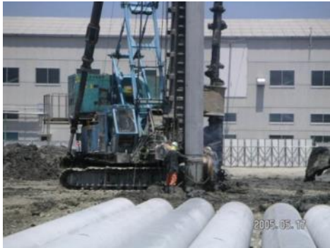
図 4-2-4：杭打ち（継ぎ杭作業）
