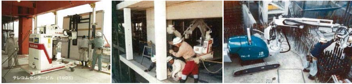
図3：使い続けられる建築用ロボットの例（左：外壁PC板取付装置、中央：プレキャストコンクリート柱位置決め装置、右：重量鉄筋用配筋ロボット）（出典：鹿島建設㈱）
