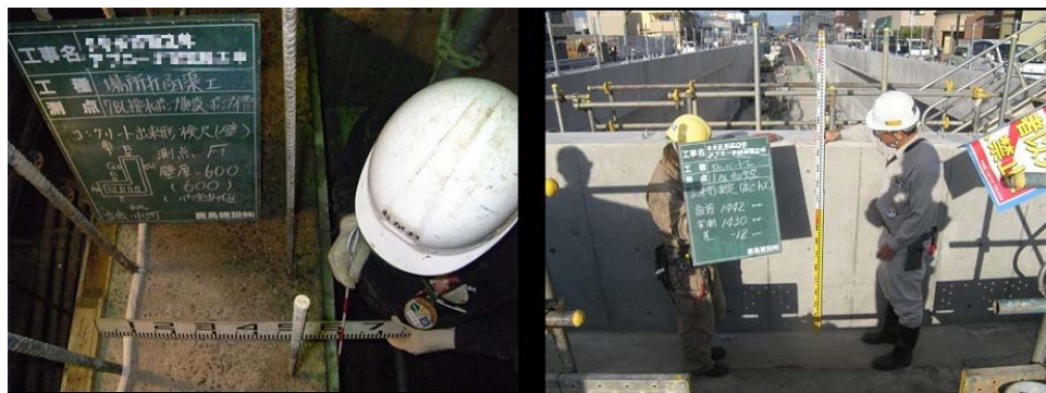
図 4-2-3 : 躯体出来形測量
