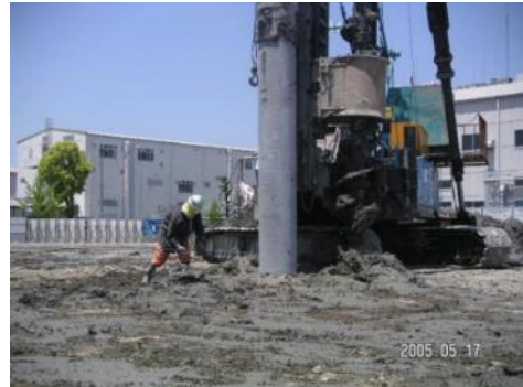
図 4-2-5 杭打ち：（芯ずれ確認・修正）
