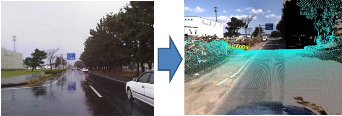
図 30 MMS を用いた平常時と災害発生後にながれきが積みあがった道路の比較 (データ提供：(株)パスコ)
