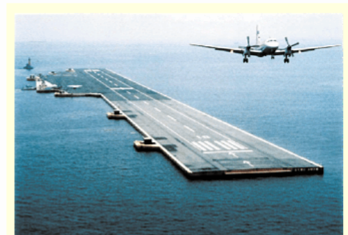
(b) メガフロート実証実験試験体[2]
