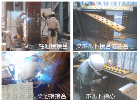
図 4. 1. 1. 1 S 造の接合状況
