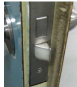
図3. 1. 9 ラッチ構造の例
