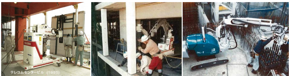
図5. 1. 1. 1. 3 使い続けられる建築用ロボットの例
