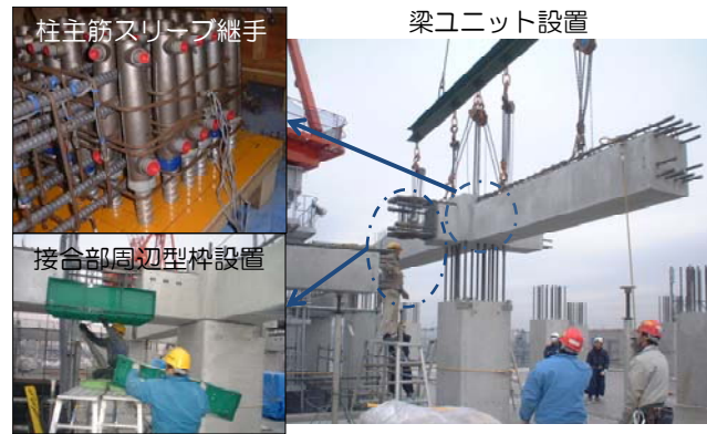
図 4. 1. 1. 2 PCa 造の接合状況
