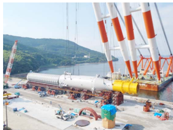
(d) 大断面部材・スパー型浮体(7.8mφ×80m) ：五島列島沖プロジェクト[3]
