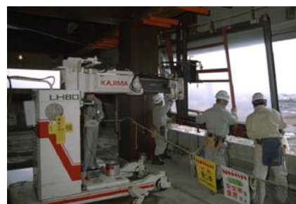
図4. 2. 2. 1 施工用ロボットによる外装材の接合作業
