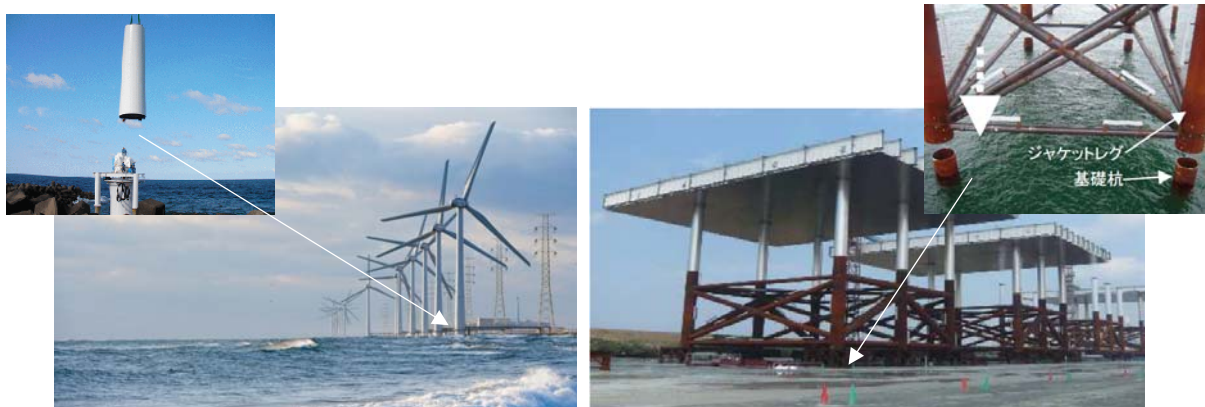
図4. 4. 2. 3 グラウト接合部の概要
