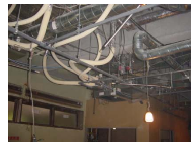
図 4. 3. 1. 4 基準階の天井設備
