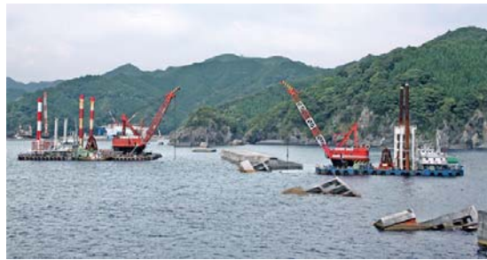
図 5. 4 大型構造物の損壊状況例（釜石港防波堤）
