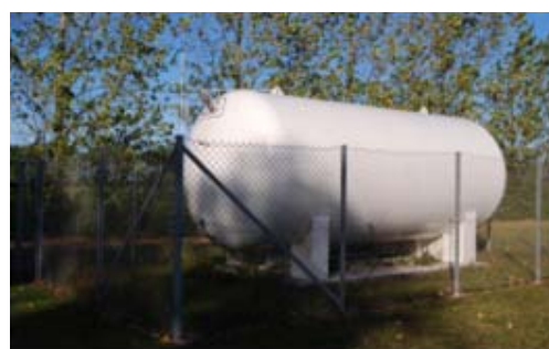
別図 1.2.3 水の電気分解で発生した水素を貯めるタンク
