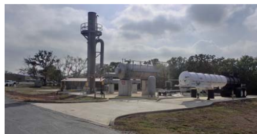
リアル・モック・アップ（塔槽類）
