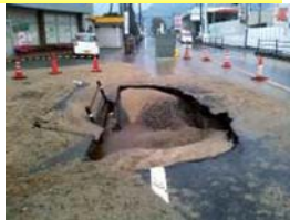
(A) 圧力水噴出による路面二次災害
