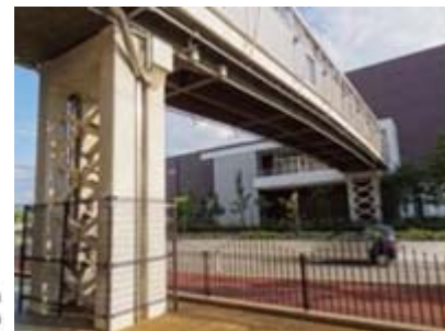
実橋梁への設置
