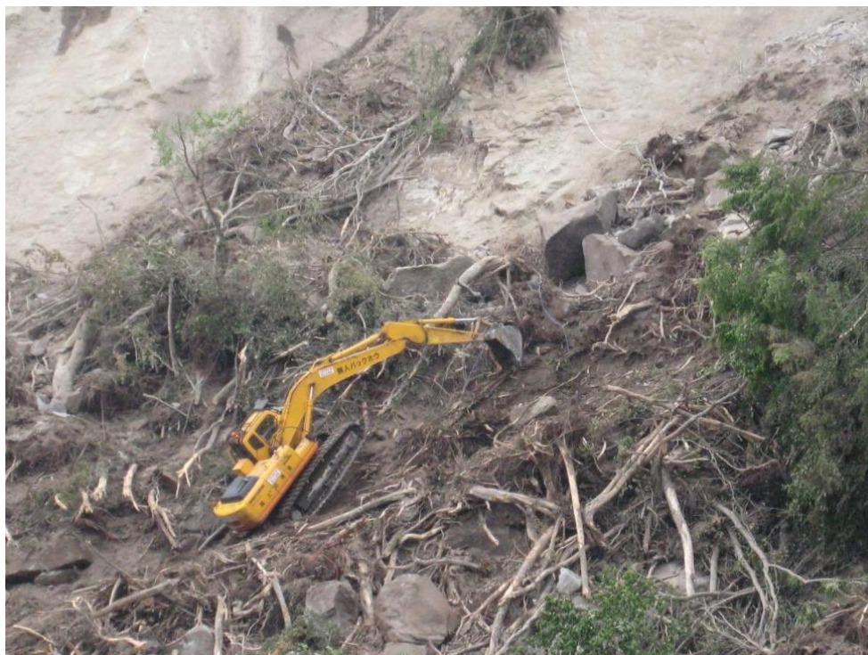
写真4 無人化施工における崖部土砂撤去での不安定作業状況
