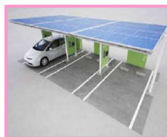
PHV/EV用充電施設の拡充 (11箇所(21基)は設置済み)
