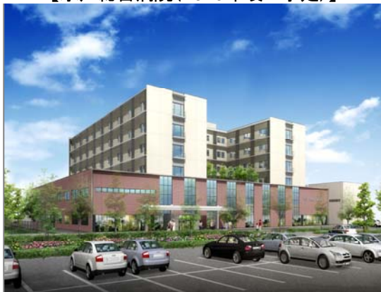
【水戸総合病院(2010年竣工予定)】
