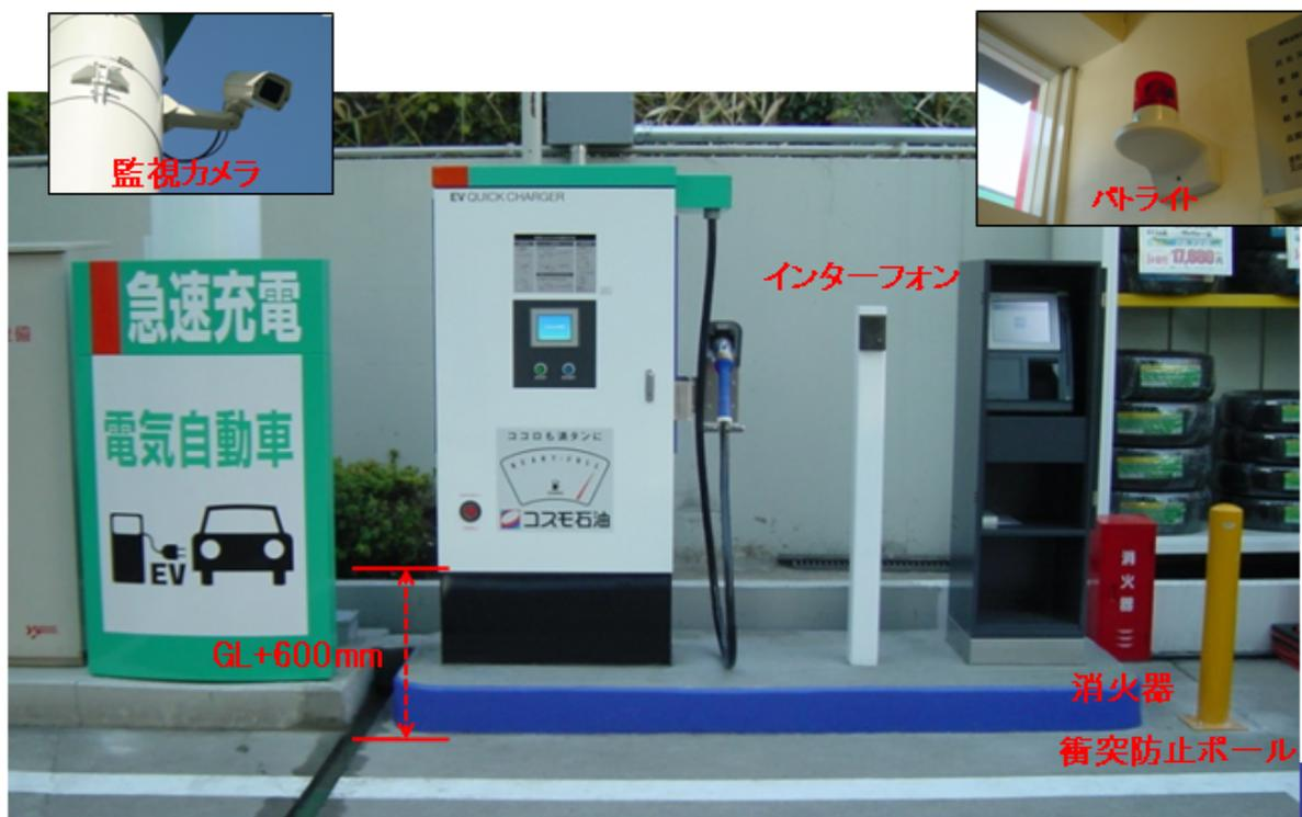
図 11-3 NEW江東SSに急速充電器を設置する際の設備面の条件(コスモ石油提供)
