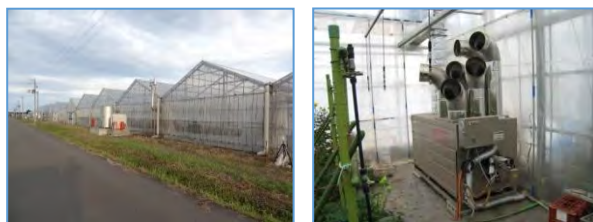
図3 施設園芸で使用される燃焼式暖房機
