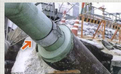
道路や橋が崩壊してもガス漏れしなかった中圧導管
